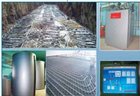
Sistem cu pompă de caldură de 10kW care asigură încălzirea prin pardoseala radiantă în Casa Solară
