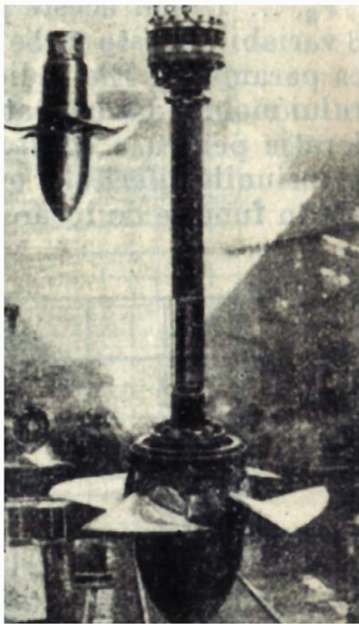
Figura 6. Rotorul Kaplan model împreună cu arborele și rotorul turbinei prototip de la C.H.E. Târgu Mureș.
