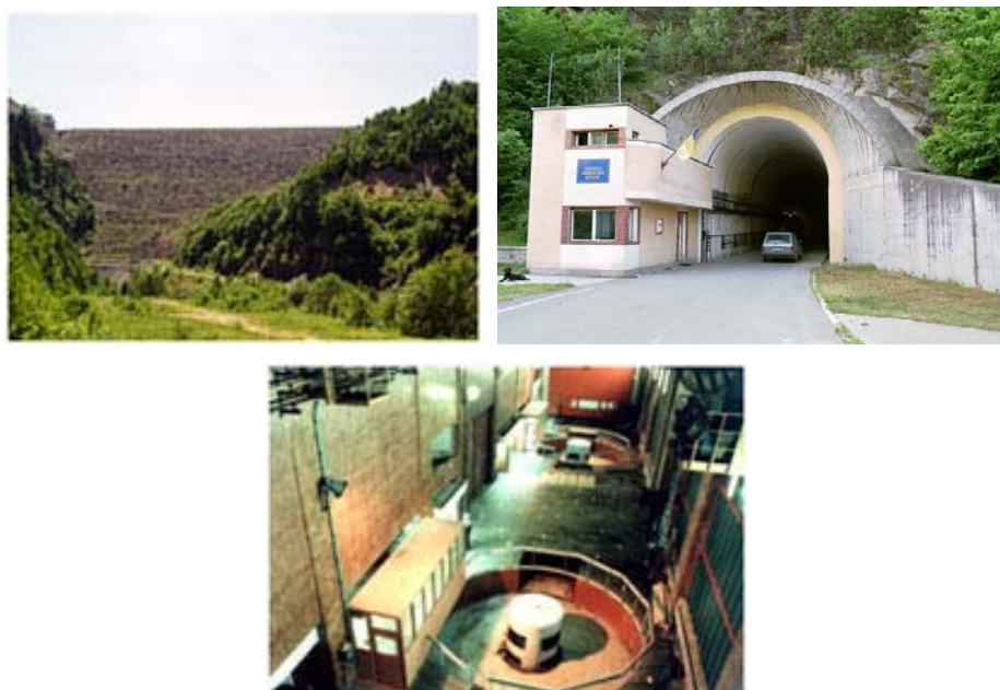
Figura 17. Barajul de la Gura Apei, intrarea în tunelul de la CHE Râul Mare, și sala mașinilor.
