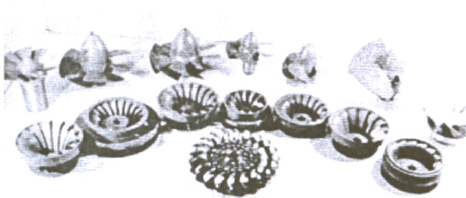
Figura 15. Componente ale turbinei de la Porțile de Fier I, în hala mecanică de la UCM Reșița (sus). Rotoare de turbine studiate la Reșița (jos).
