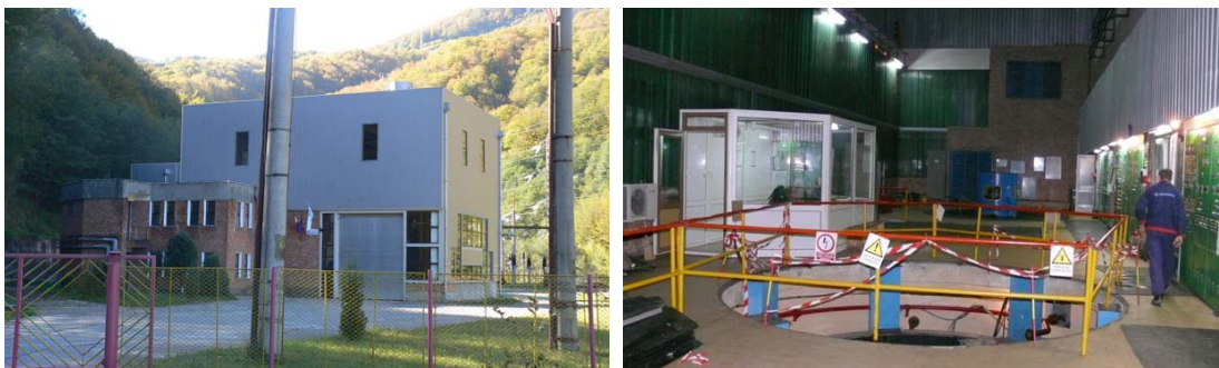
Figura 26 . Centrala hidroelectrică Munteni.
